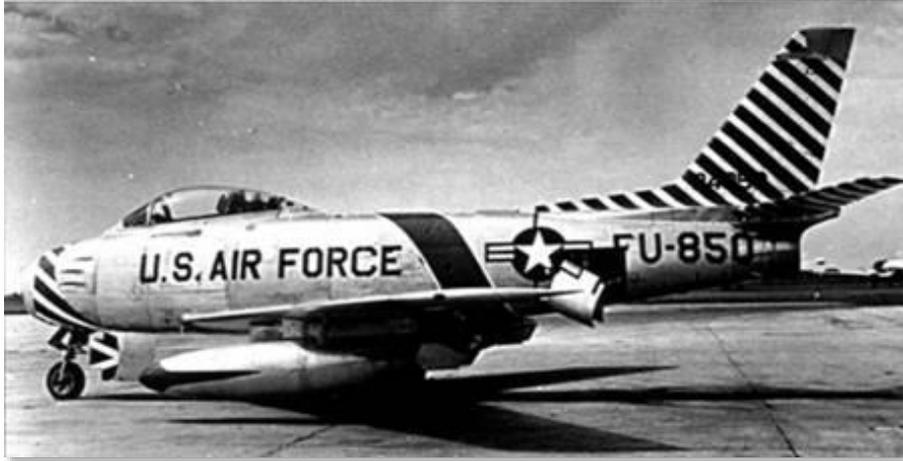
图 1.17 带有 Mk.12 炸弹模型的 F-86F-35 战斗机
